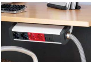
При большой плотности компоновки рабочих мест, можно использовать специальные офиблоки для размещения рабочих мест непосредственно на столах или под столешницей. В этом случае сервисные колонны могут использоваться для организации кабельных трасс, без установки в них розеток.
